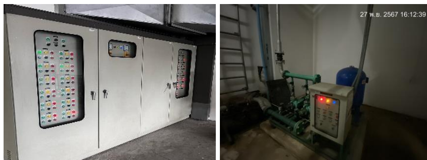
ตู้ควบคุมระบบบำบัดน้ำเสีย
