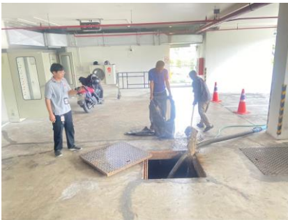
การสูบลากตะกอนไขมันส่วนเกินระบบบำบัดน้ำเสียประจำปี (วันที่ 16 พ.ค. 67)
