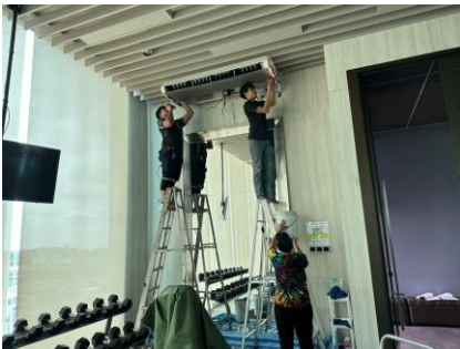
รูปที่ 2.1-14 การตรวจเช็คบำรุงรักษาระบบปรับอากาศ (ส่วนกลาง)
