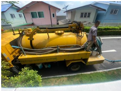
การสูบลากตะกอนไขมันส่วนเกินระบบบำบัดน้ำเสียประจำปี (วันที่ 16 พ.ค. 67)
