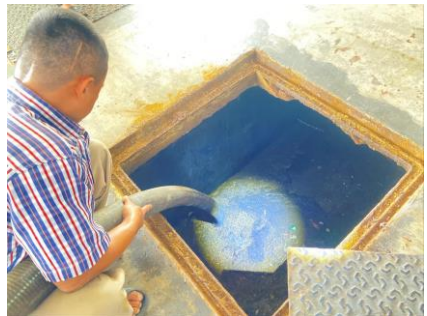
การสูบลากตะกอนไขมันส่วนเกินระบบบำบัดน้ำเสียประจำปี (วันที่ 16 พ.ค. 67)
