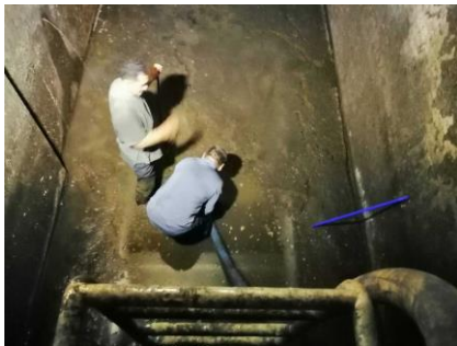
การสูบลากตะกอนไขมันส่วนเกินระบบบำบัดน้ำเสียประจำปี (วันที่ 16 พ.ค. 67)
