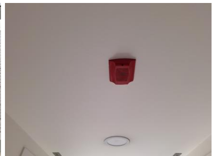
ลำโพงเตือนสัญญาณไฟไหม้
