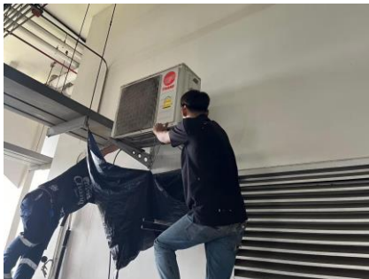
รูปที่ 2.1-14 การตรวจเช็คบำรุงรักษาระบบปรับอากาศ (ส่วนกลาง)
